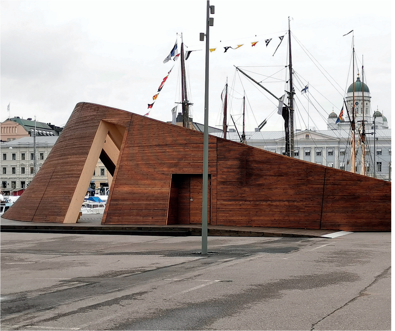
Paviljongin on lupa olla nykyisellä paikallaan vuoteen 2024 asti, ja se voidaan tarvittaessa siirtää kohtalaisen helposti toiseen sijaintiin, sillä rakennusta varten ei tarvittu kiinteitä kiinnikkeitä tai kaivauksia.
