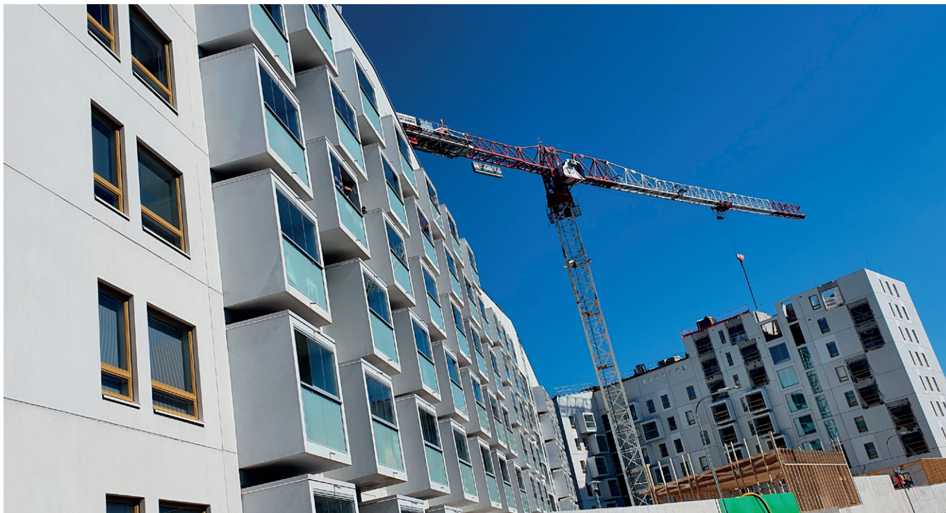
Firan työmaalla Kontulassa rakentuu uusia kerrostaloja.
