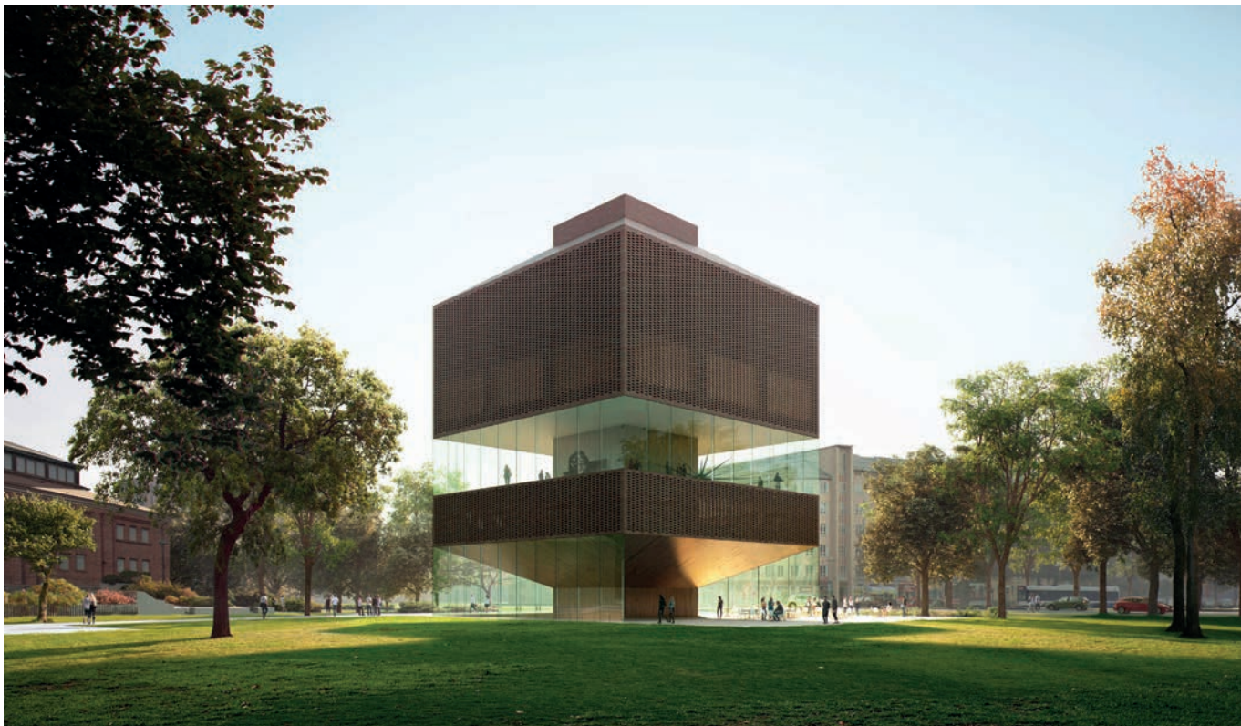
Museon lähialueen puistomaisen luonteen säilyttämiseksi museolaajennus suunniteltiin jalanjäljeltään mahdollisimman kompaktiksi tornimaiseksi massaratkaisuksi. Maanpäällinen uudisrakennus sijoitettiin niin, että se näkyy Pirkankadulta museota lähestyttäessä ja muodostaa samalla päätteen Keskustorilta museolle johtavalle Puutarhakadulle. Kuva: AOR Arkkitehdit
