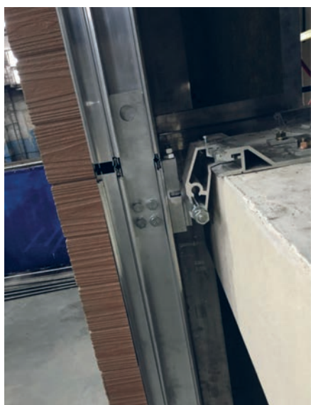
Seinäpaneelin liitokset tehtaalla. Kuva: Dutch Architectural Studio
