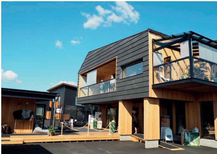
Talo Haltiattaressa oli käytetty kovassa nousussa olevia CLT-puuelementtejä.
