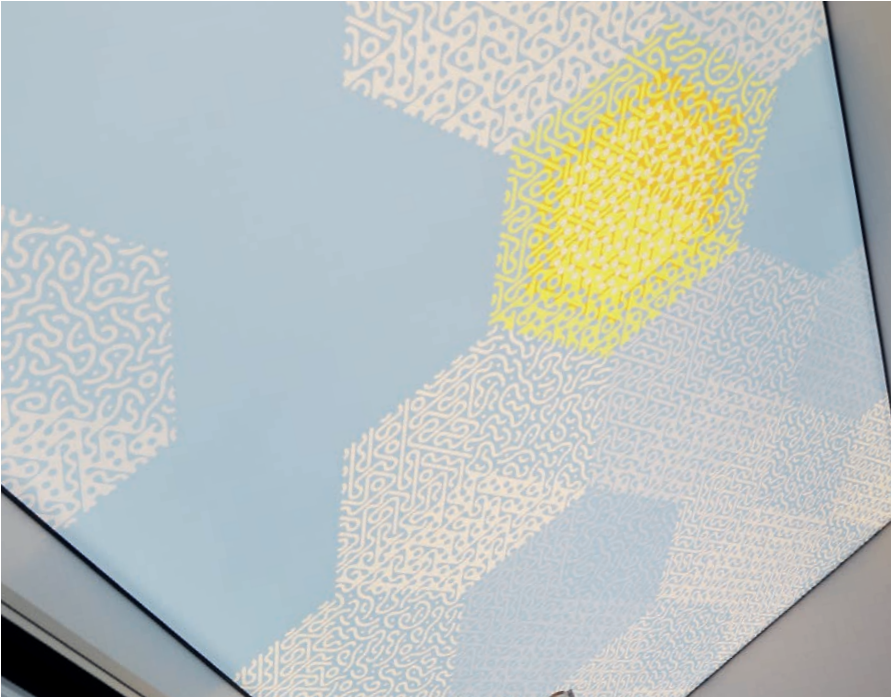
Sisääkäyntiaulan katto vaikuttaa ensi näkemältä kattoikkunalta.
