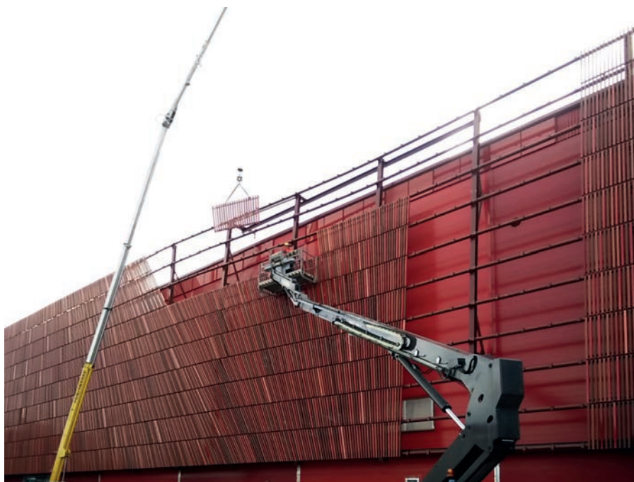
Julkisivuelementtien asennusta paikalleen.
